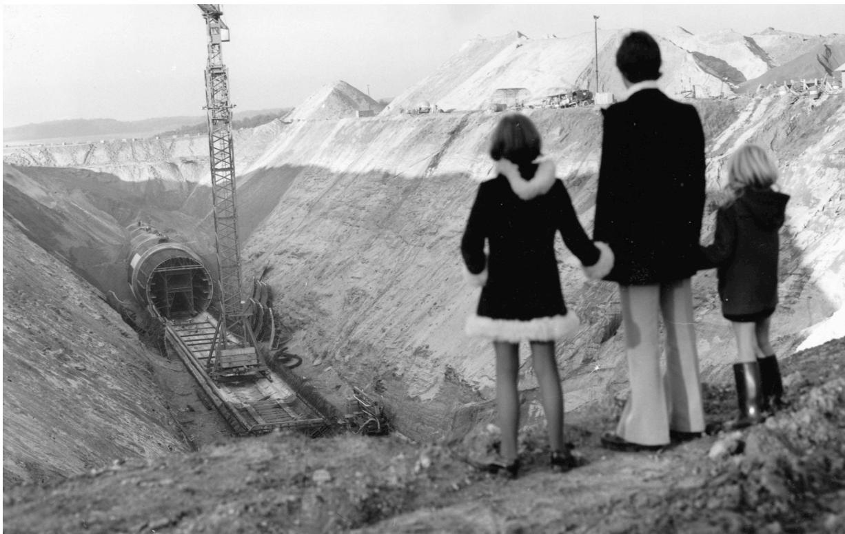
1973 - Chantier du raccordement ferroviaire Ottignies – Louvain-la-Neuve. La ligne est ouverte le 1 er septembre 1975.
