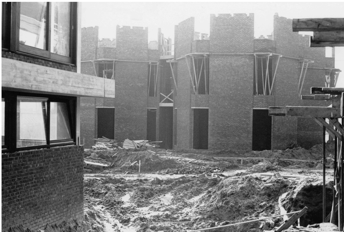
1971 – 1974 Construction du quartier des sciences exactes. Photo : future Place Sainte-Barbe.
